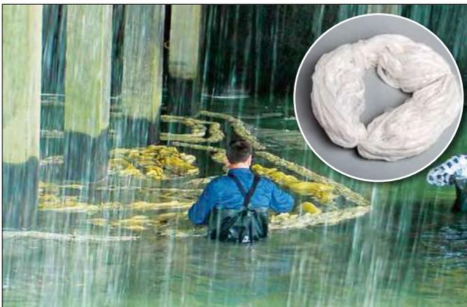
Fibras REO Fb usadas para eliminar aceite hidráulico de la piscina de refrigeración de una planta eléctrica.
